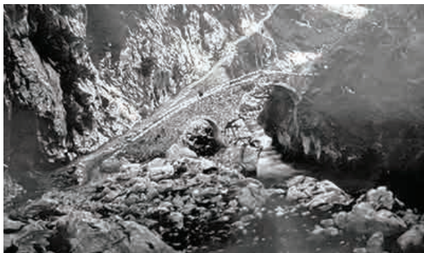
El bellissimo y audaz puente viejo de Poncebos, una joya más que tendría esta zona si no hubiese sido destruido –al parecer, innecesariamente– al hacer las obras de la Central. Detrás del puente, el entonces frecuentado Camín de La Rumiada, vía para llegar a Telve y a Sotres.
