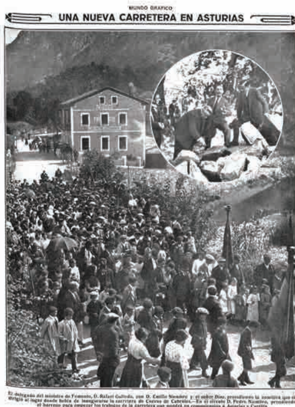
1916, acto de inicio en Arenas de las obras de la carretera que llegaría hasta Poncebos.
