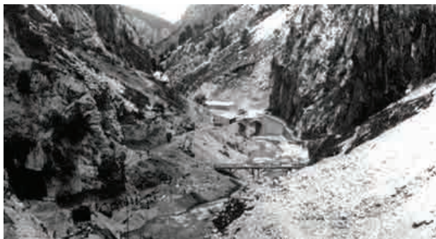
Ajetreo de obras en Poncebos: la modernidad se abre camino en los Picos de Europa...
