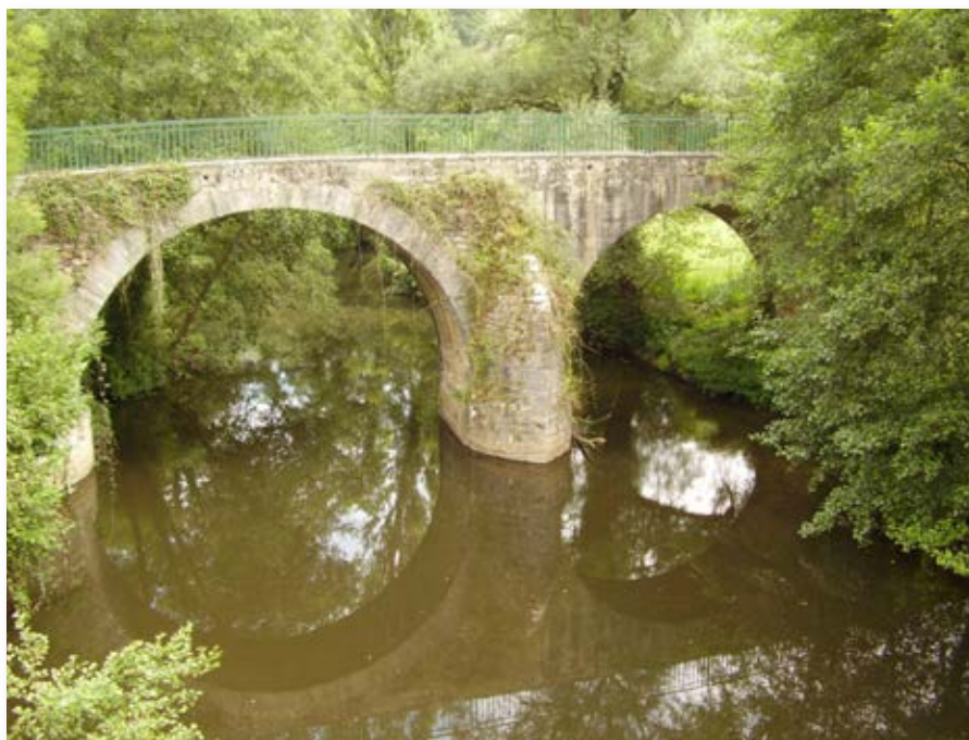
Puente Gallegos (Foto: Pepín Menéndez)
