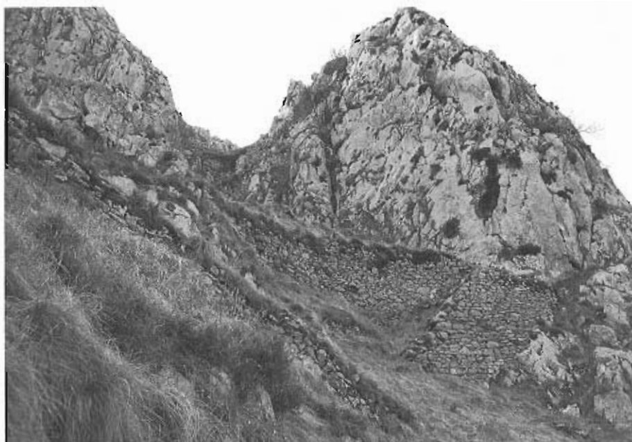
Camino edificado sobre muros en la zona entre las dos galerías
