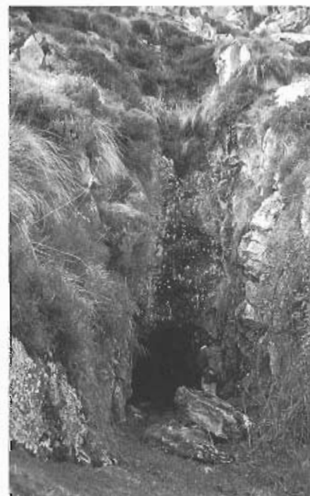
Hendidura producida por la excavación del filón de man- ganeso.
