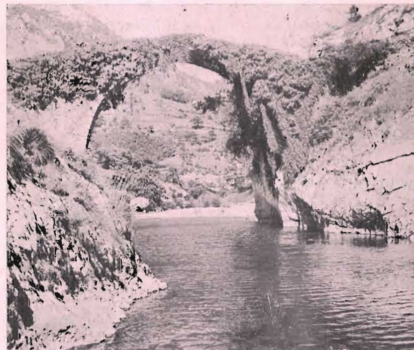
Puente romano, en la carretera de Cabrales
